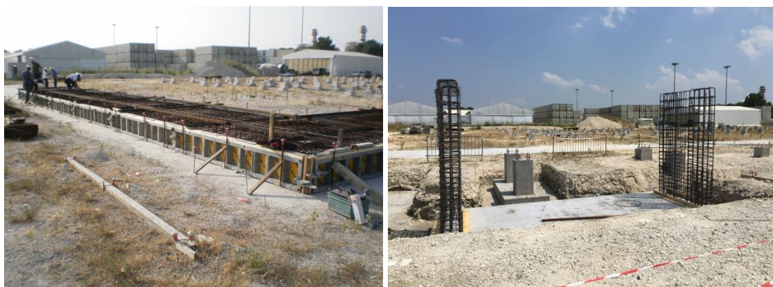
Foto: cantiere nuova torcia
